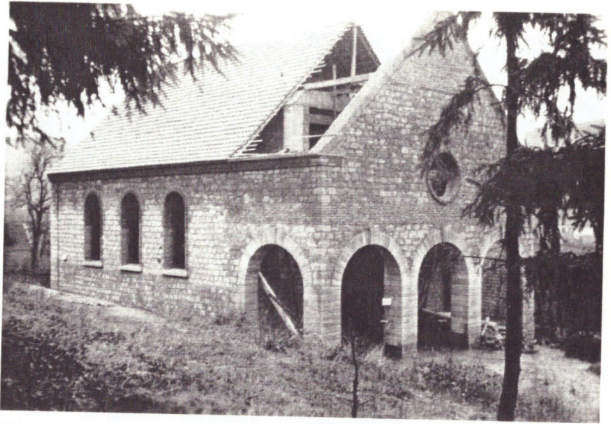
Bild 16: Kapelle vor der Fertigstellung des Rohbaus (1952)
