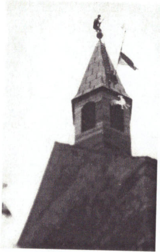
Bild 20: Aufsetzen des Turmhahnes durch Dachdecker Robert Guthörl, Illingen. Der Hahn selbst wurde von Alois Latz, Berschweiler angefertigt.
