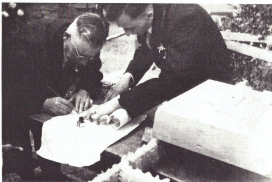
Bild 8: Grundsteinlegung am 03.06.1951. Unterzeichnung der Urkunde durch: Valentin Molter (†), Bürgermeister der Gemeinde Berschweiler (li.) und Geschäftsführer des Kapellenbauvereins Hans Keller (†), re. im Bild.
