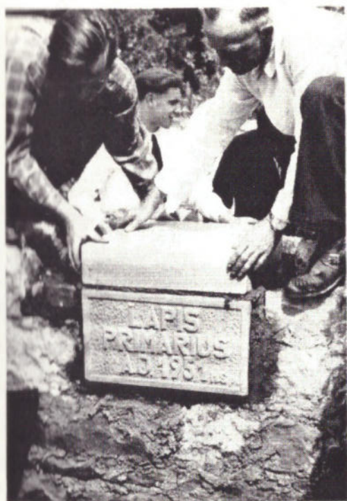
Bild 11: 1951. Vermauern des Grundsteines durch Roland Wagner (li.) und Vater Alfred (†). Im Hintergrund: Hans Engel (†)
